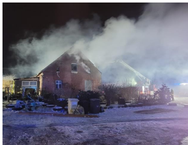
Fot. 29. Pożar budynku mieszkalnego w Rychliku.
