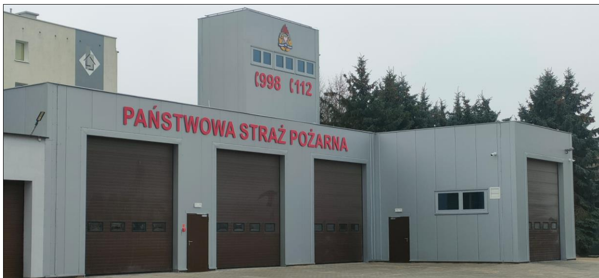
Fot. 85. Rozbudowa budynku JRG PSP w Trzciance.
