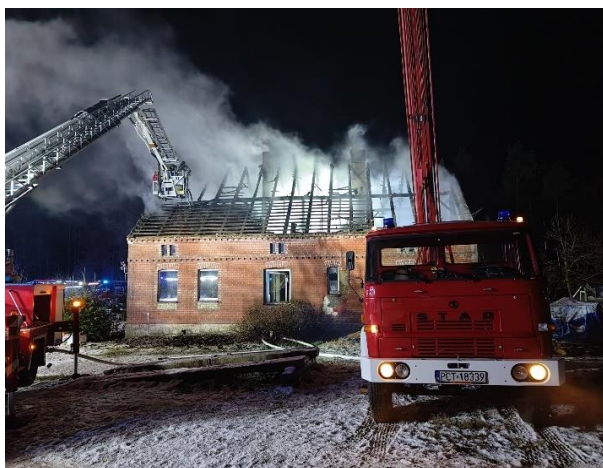
Fot. 28. Pożar budynku mieszkalnego w Rychliku.
