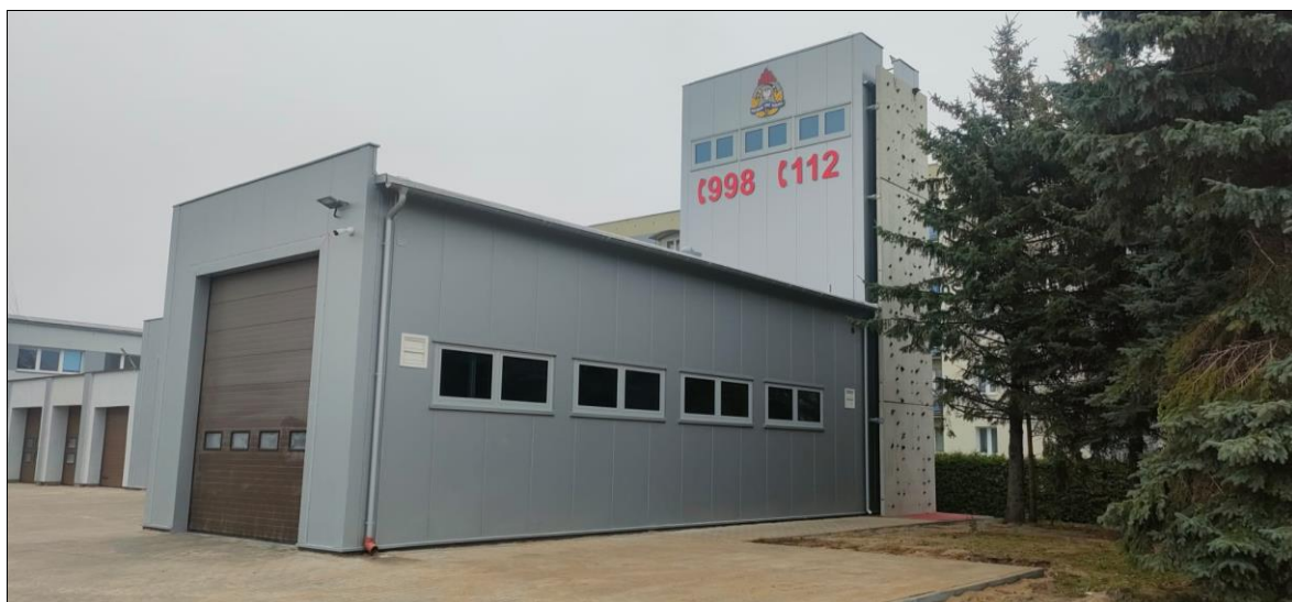
Fot. 86. Rozbudowa budynku JRG PSP w Trzciance.
