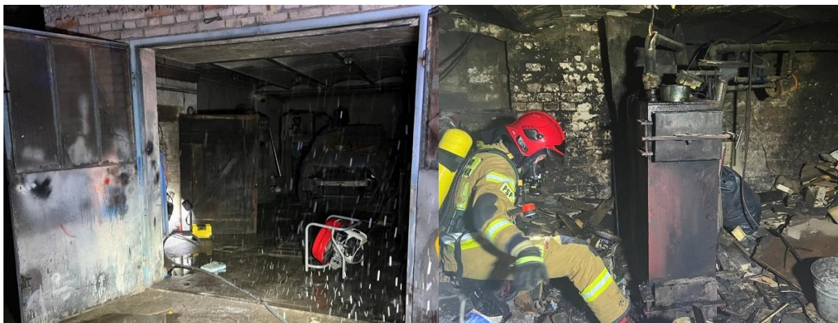
Fot. 30. Pożar kotłowni w Trzciance.
