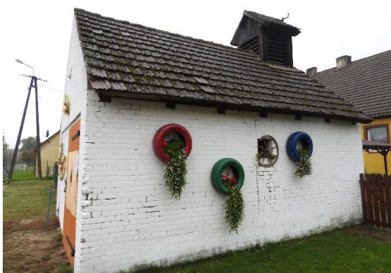
Zdjęcie nr 19 – Dawny budynek strażnicy OSP
